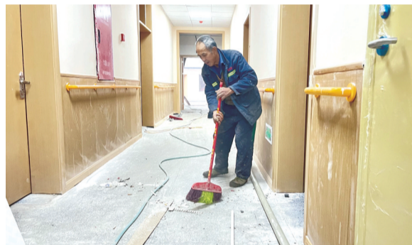
▲老人们在清江镇养老服务中心内享受“下午茶” ▲仁义镇养老服务中心主体工程完工,工人正在做清洁。
