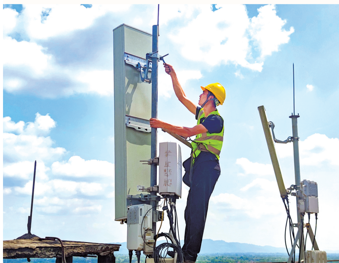
工程技术人员安装基站设备
