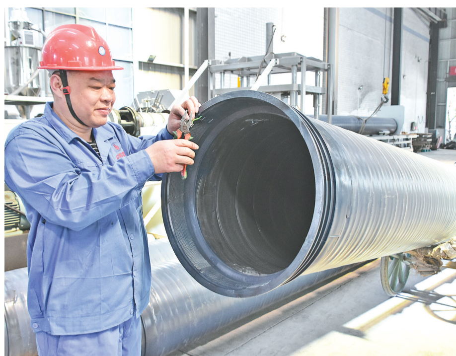
工人检查管道的承插电熔管接头
