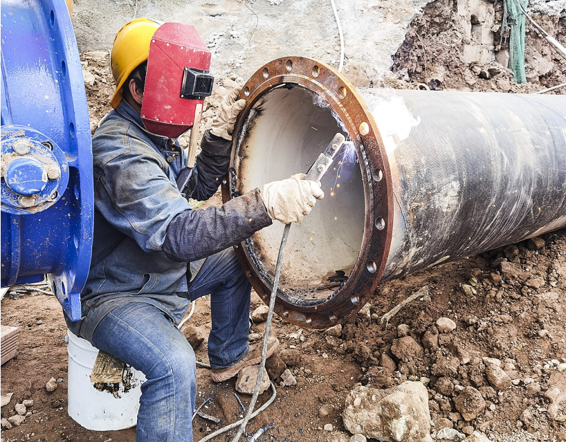
工人焊接管道
