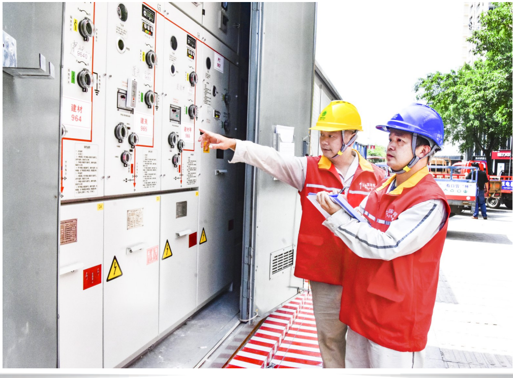
验收老旧小区电力设备改造
