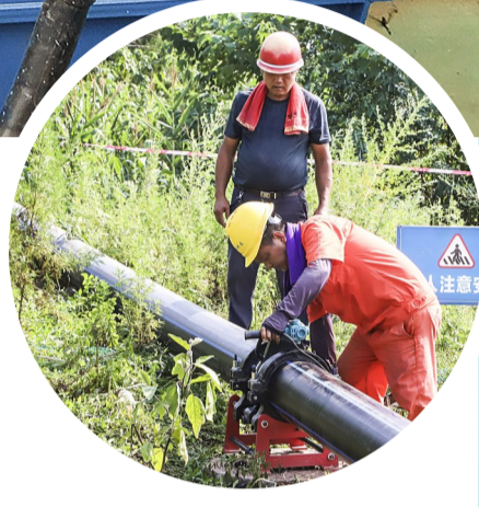
工人安装管网
