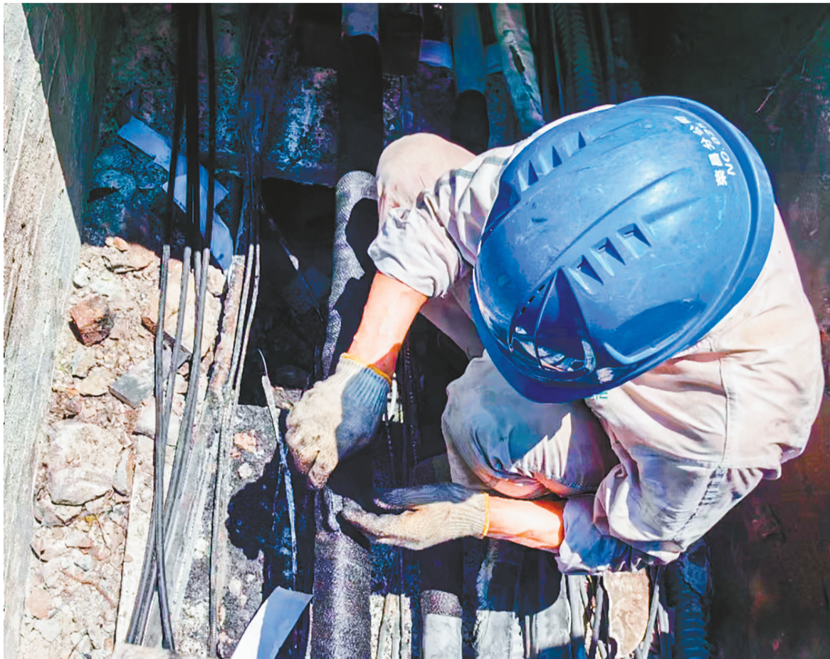
电力工人井下抢修
