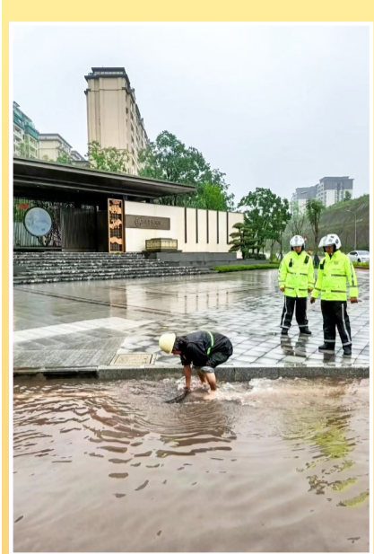
区住房城乡建委工作人员疏通排水井盖和雨水篦子
