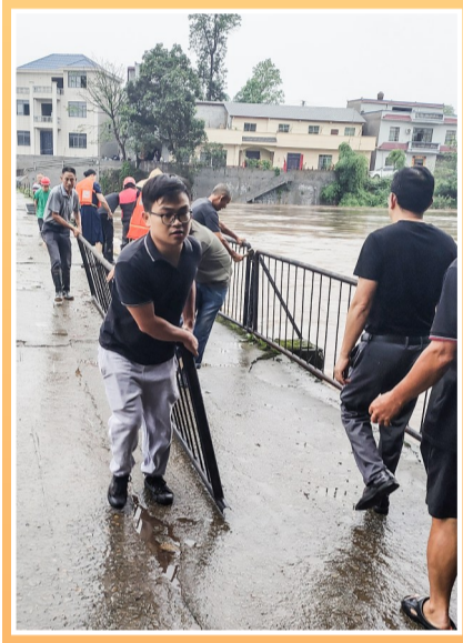
清江镇工作人员拆除人行桥护栏减少洪水阻力
