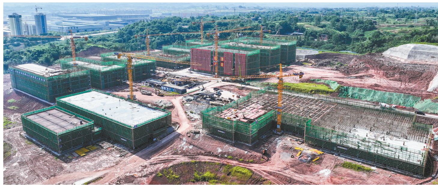
项目建设现场
