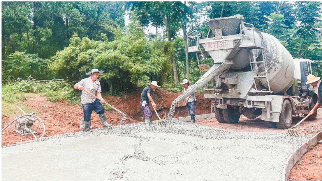
近日,在吴家镇肖家湾公路硬化施工现场,伴随着混凝土搅拌车的轰鸣声,工人们有序铺设水泥混凝土路面。肖家湾公路总长3公里,宽4.5米,因修建时间久远,路面未进行硬化,导致路面破损严重,给周边群众出行和生产造成
