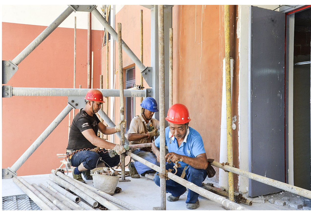
扎钢筋、搭钢架……近日，在直升镇荣升街场镇品质提升项目施工现场，老旧小区改造工程正如火如荼进行，工人们各司其职，现场忙碌而有序。 该项目建设内容主要包括老旧小区改造、雨污管网施工、配套基础设施改造、强弱线规整、绿化提升等，预计今年底完工。 融媒体中心记者 张 雪 实习生 向星睿 摄
