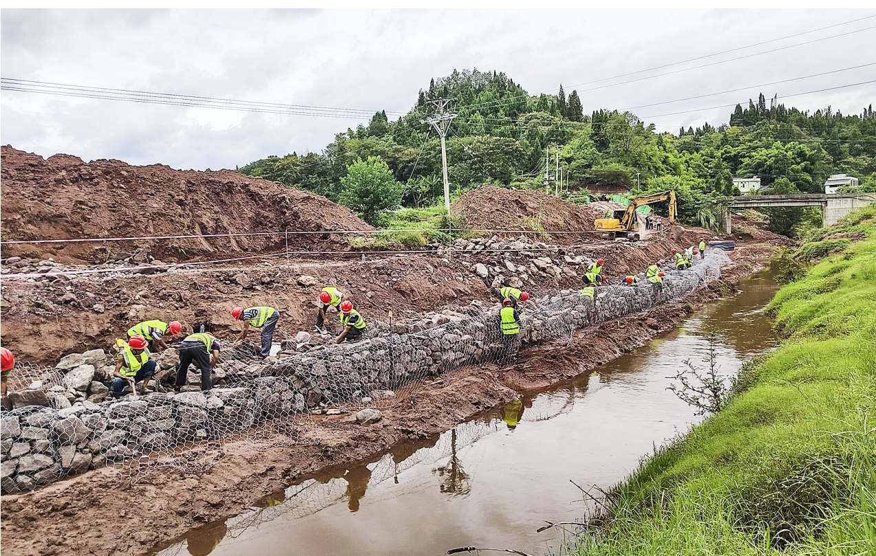
连日来,马鞍山综合治理工程现场,施工方正抢抓有利天气,调派技术人员和工程设备,加快推进项目建设作业。 “马鞍山综合治理工程于6月底开工建设,整治内容包括河道清淤疏浚以及建设堤防、堤顶道路、人行桥等附属设施等。”项目负责人说,下一步,将加快建设步伐,力争年底项目主体完工。 融媒体中心记者 曹让均 摄
