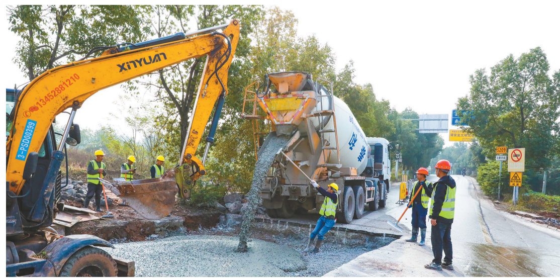
12月6日,在S209荣江路直升岔路口处,挖掘机、搅拌机机械同时作业,施工人员忙着进行路面改造,解决公路破损、积水问题。 据了解,区交通工程建设中心组织工作人员持续深入辖区各镇街,开展道路安全巡查,排查道路安全隐患。巡查中,了解到该路口存在积水问题后,于上月中旬启动该处路面改造工程,保障群众出行畅通、便捷。该项目预计本月底全面完成。
